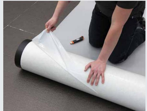
Ausrichten der Dachbahn bis zur Hälfte der Rolle, Einschneiden der Schutzfolie und abziehen
