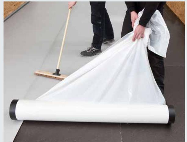
Abziehen der Schutzfolie parallel zur Rolle, Andrücken der Dachbahn auf den Untergrund mit einem sauberen, breiten Besen oder einer Rolle
