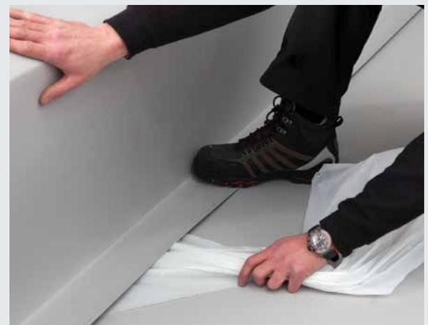
Anschluss an die Attika mit SK-Zuschnittbahn, Zuschnitt vorformen, Schutzfolie oben und unten parallel zur Kehllinie einschneiden und schrittweise abziehen, Zuschnitt andrücken
